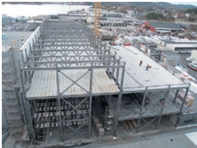
Fabrikkbygningene begynner å ta form, mars 2008.
