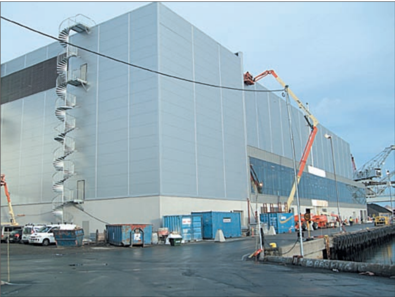
Elkem Solar-anlegget består til sammen av 6 hovedbygg og flere hjelpebygg på til sammen ca. 22.500 m². Nybygg utgjør 16.500 m², mens 6000 m² omfatter eldre bygg som er rehabiliterte.
