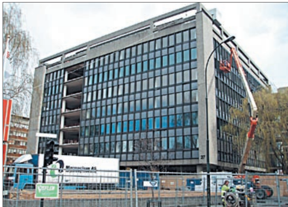
Fra arbeidene med utskifting av vinduene i M27 mars 2007.
