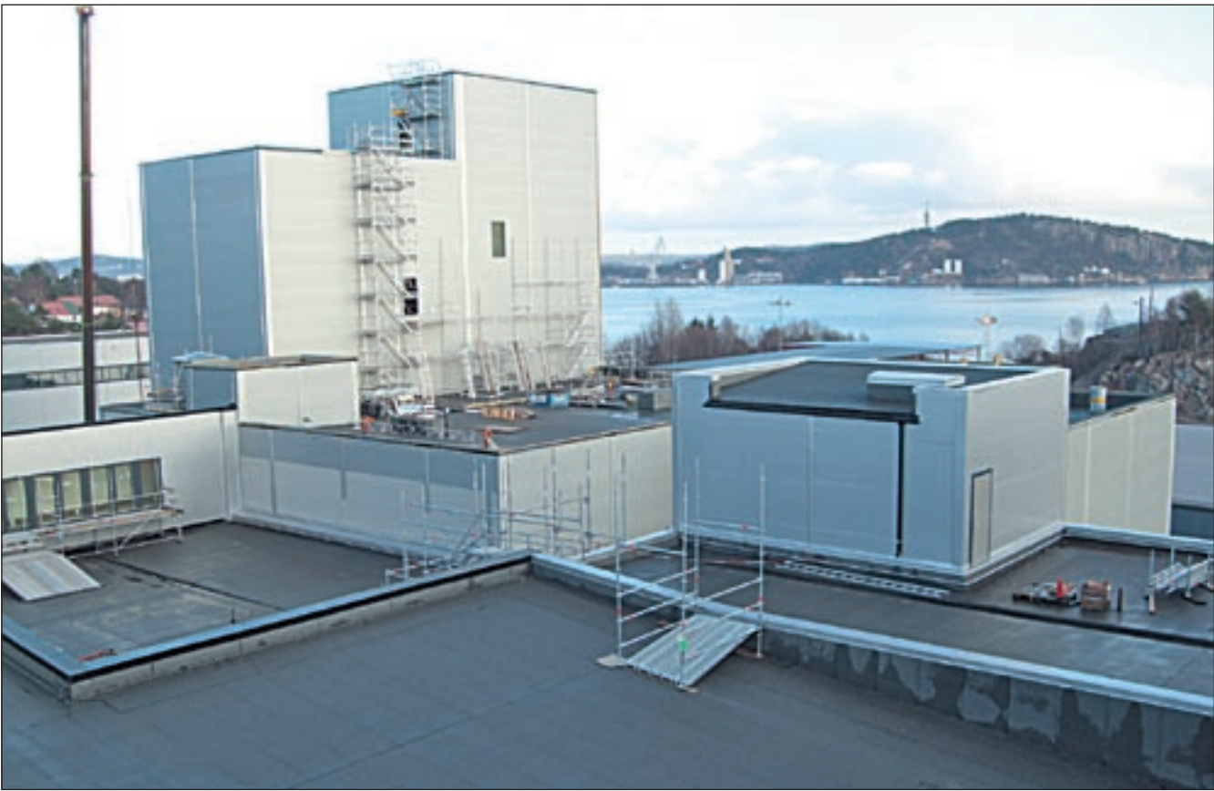
Fabrikken fremstår nå med et moderne og stramt uttrykk som kan kjennes igjen i de krav som stilles til orden og struktur i produksjonsprosessen ved anlegget.
