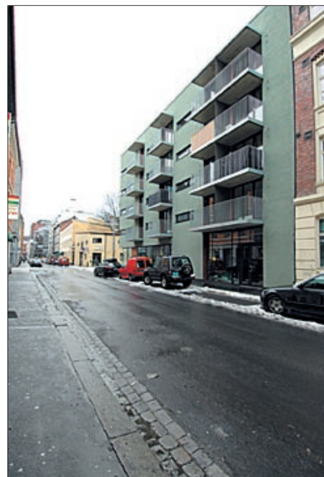
Calmeyers gate sett mot vest. Her ligger inngang til matvarebutikken.
