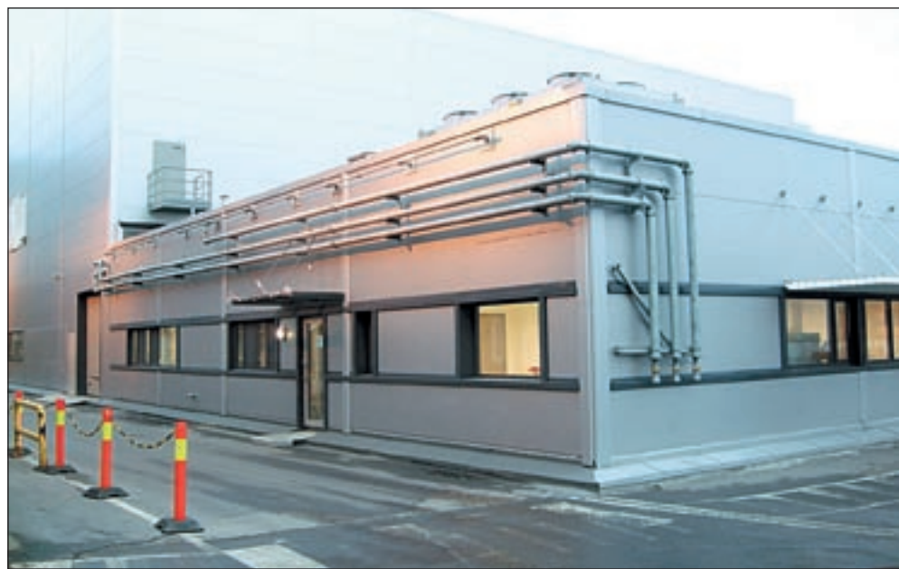
I laboratoriebygget er det i all hovedsak benyttet vannbåren gulvvarme som oppvarmingssystem. Det benyttet isvannsmaskin med takmontert tørrkjøler. Romkjøler i serverrom har back-up med nettvann.
