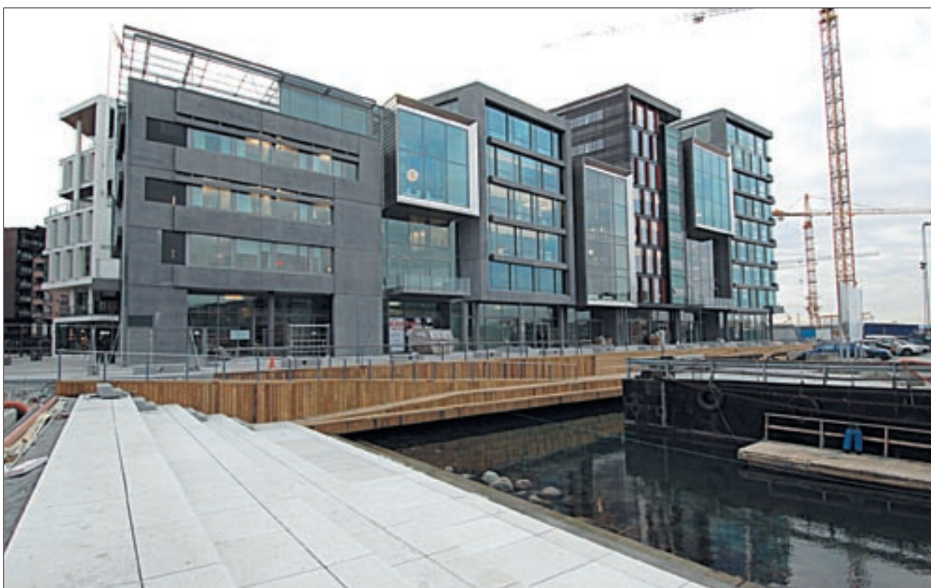
Vestfasaden er variert i uttrykket. De 3 glassboksene i vestfasaden stikker opptil 1,5 meter ut fra fasaden. 3 lektere i Filipstadbukta tjener som riggområde og arbeidsplattformer.
