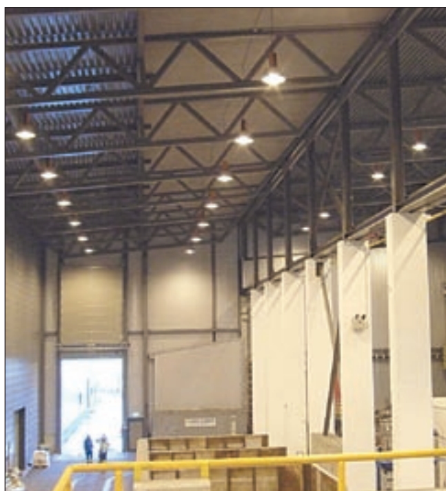
Stålfagverk bærer takene.
