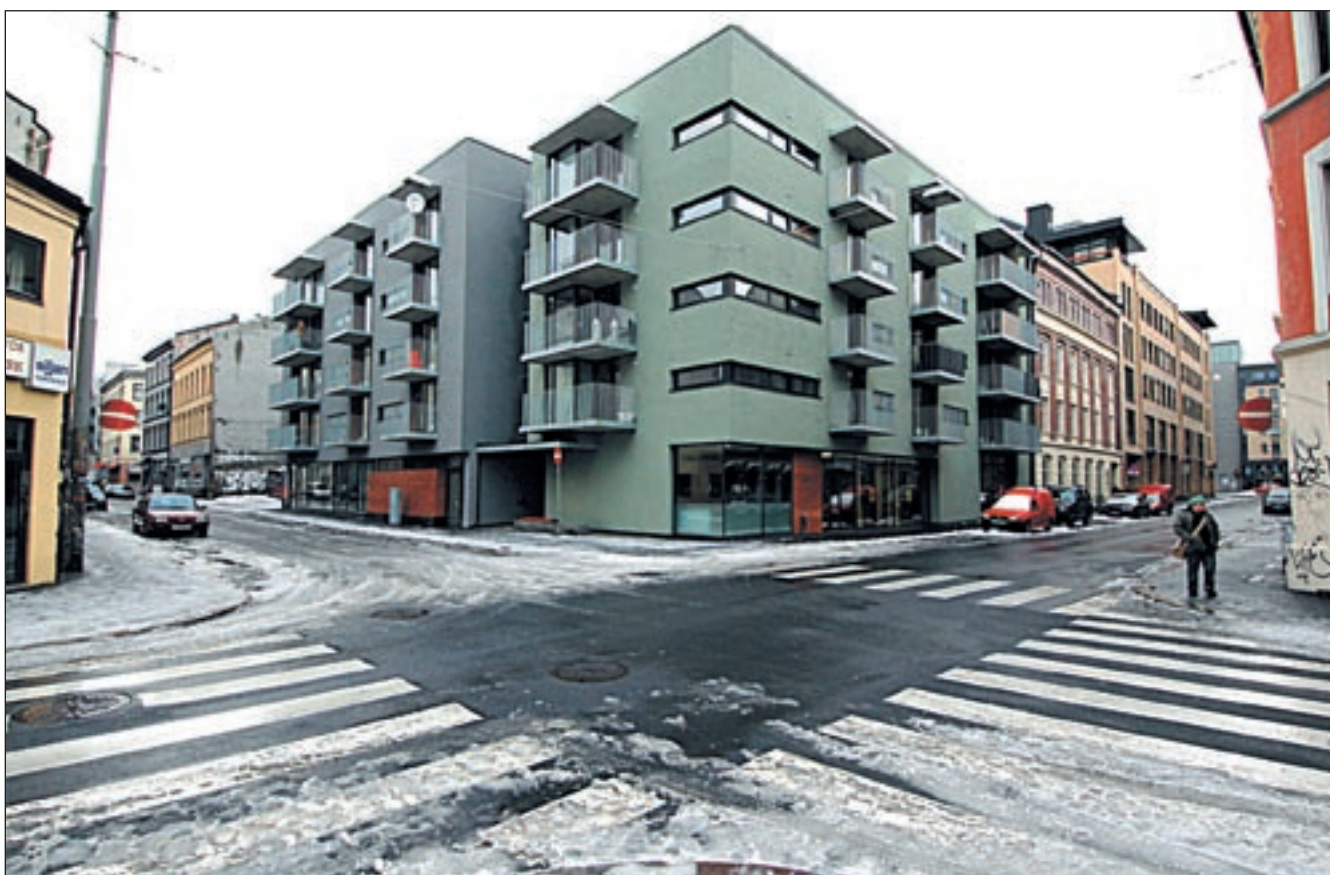
Prosjektet ligger på hjørnet av Calmeyers gate og Osterhaus' gate i Hausmannskvartalene i sentrum av Oslo. Området er et mangfoldig område med flere typer næring, offentlige og private institusjoner og boliger.
